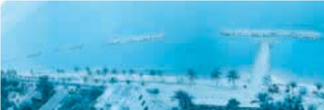
写真4 ライオン工業地帯の埋め立て地の東側に建設された防波堤。人工構造物は景観を悪くするため、観光地では防波堤建設は避けたい。しかし海岸侵食が余りに激しいため、やむを得ず防波堤の建設が行なわれている。
