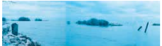
写真5 チャムから北約35kmに建設された防波堤と、自然に繁殖したマングローブ。防波堤は約10年前に建設された。自然に繁殖したマングローブは5歳ぐらい。この地では防波堤は数個建設されたが、その後マングローブが自生し、漁民の良港になっている。
